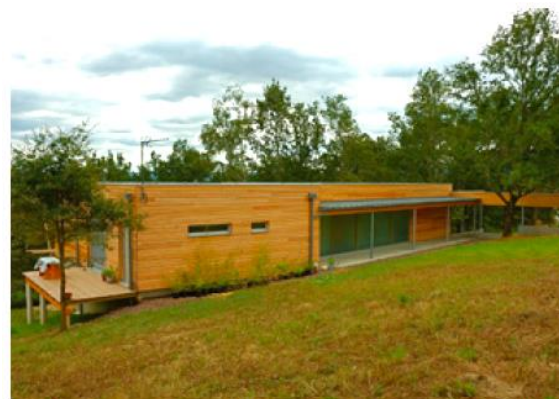
Les chênes existants ont été préservés pour une insertion dans le contexte de lisière.
